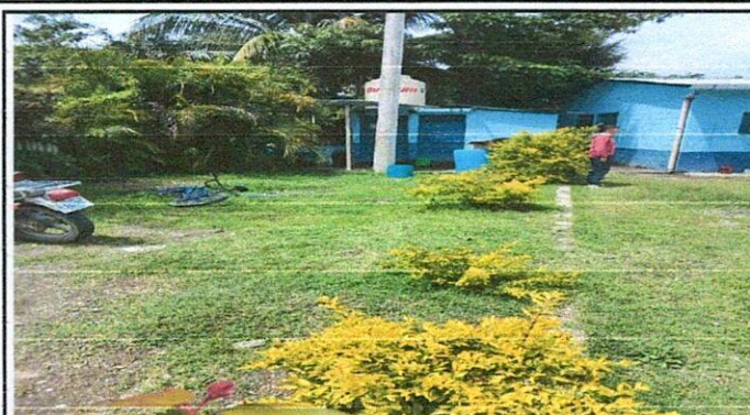
Foto 2: Reparacion de drenaje y agua potable.
